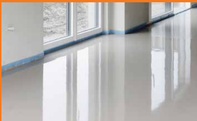
Un résultat parfait : une surface peu poreuse et extrêmement lisse qui ne nécessite pas de ponçage ultérieur.
