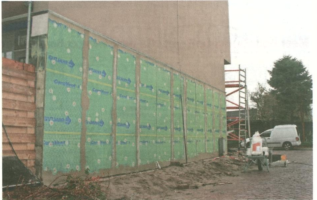
Het montagesysteem van Gutjahr, PCI en Agrob Buchtal zoals dat in Naaldwijk wordt gebruikt. Foto: PCI
