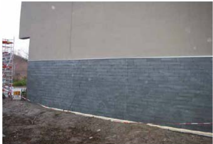
De constructie heeft een draagkracht tot een maximum van 25 kilogram per vierkante meter.
