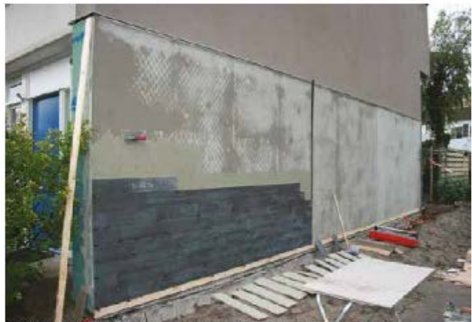
De constructie heeft een draagkracht tot een maximum van 25 kilogram per vierkante meter.
