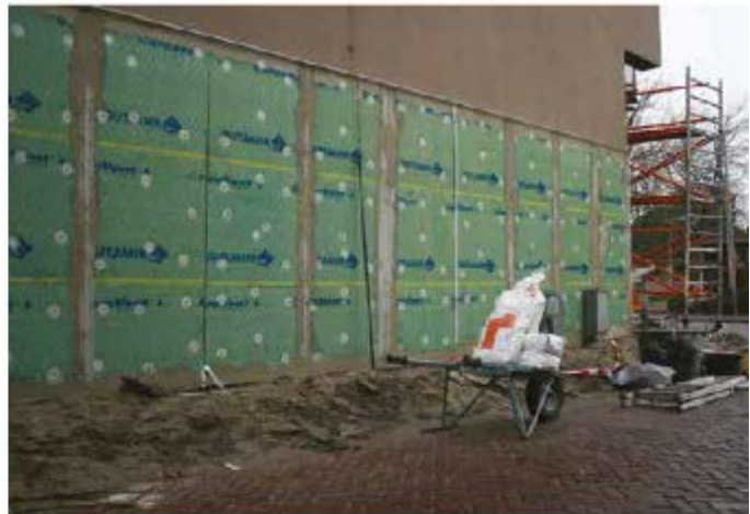
Elke mat wordt met zes ankers bevestigd aan de betonnen kern.
