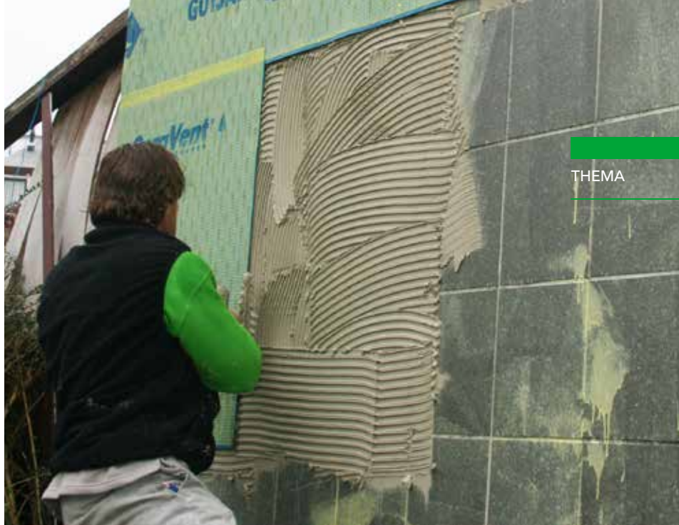
Over bestaande tegels in Naaldwijk
